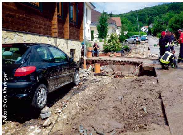
Außergewöhnliche Starkregen verursachen zunehmend große Schäden auch im Saarland (Kleinblittersdorf).
