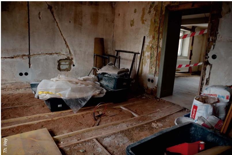
Foto vom September 2022: Lange dauerte die „Abbruch- und Rohbauphase“ mit Vorarbeiten der Decken- und Bodensanierung sowie den Installationsarbeiten Heizung, Elektrik etc.
