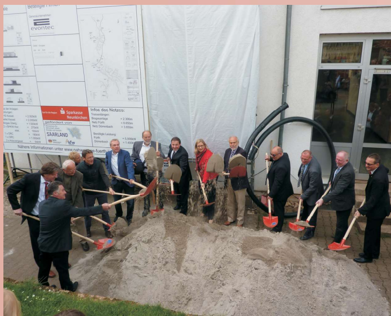
Großer Bahnhof beim Spatenstich für das Nahwärmeprojekt Fürth/Dörrenbach.
