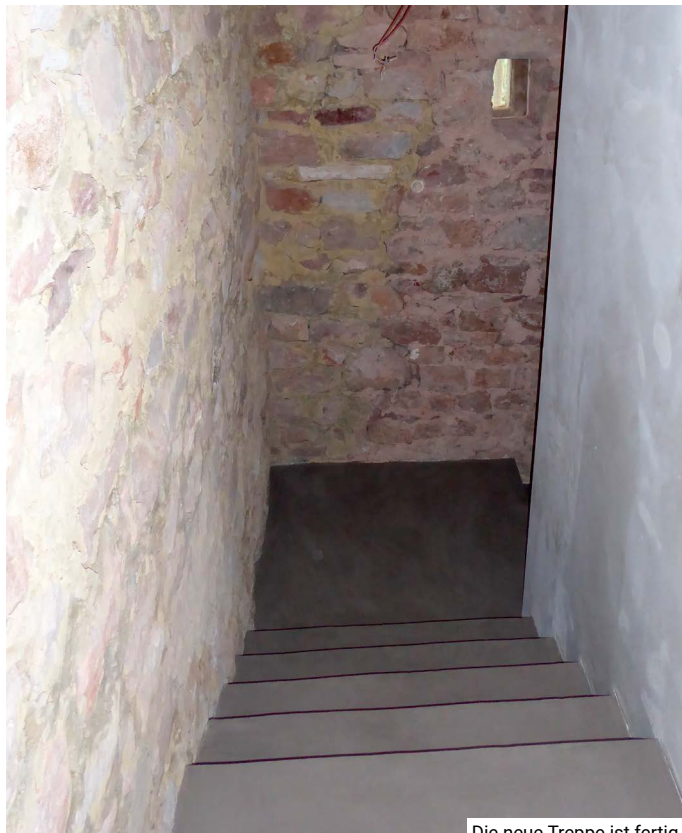
Die neue Treppe ist fertig.
