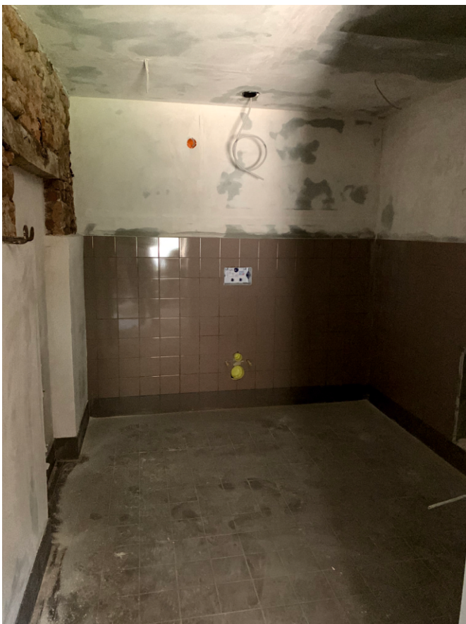
Barrierefreies WC im Bau
