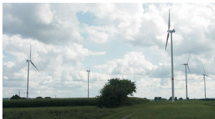
Die neuen Windräder auf dem Galgenberg bei Losheim.
