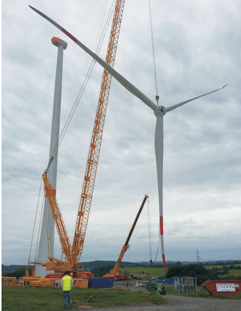
Windpark Schiffweiler - Montage Rotorblattstern.
