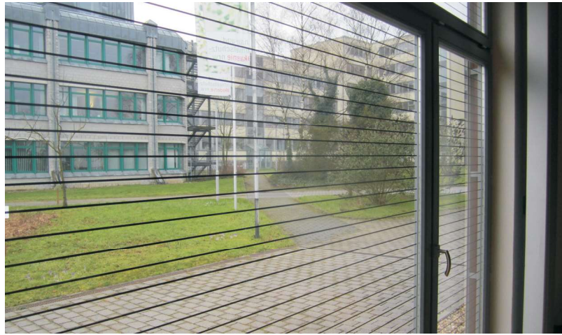
Am Seminarraum der Natur und Umweltschutzakademie NRW wurden die Glasscheiben nach einem mehrmonatigen Vogelschlag-Monitoring vogelfreundlich mit horizontalen Streifen nachgerüstet.
