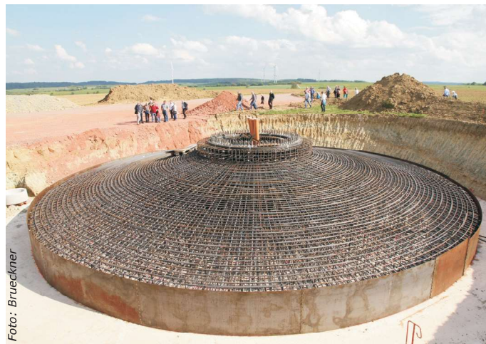
Das Fundament einer der Galgenberg-Anlagen.
