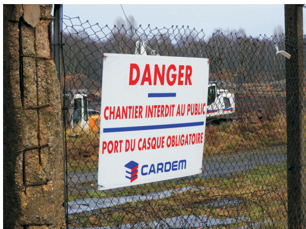
Beispiel für neue Freiflächen nach Abriss alter Chemielager.
