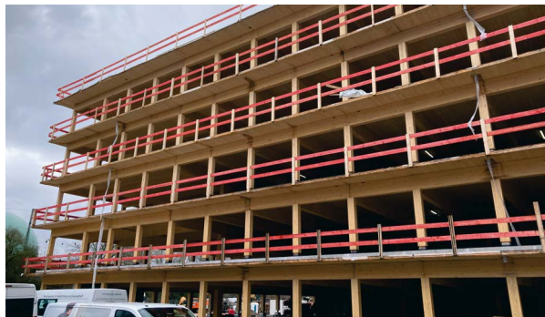
Weltweit erstes Holzparkhaus im PFAFF-Areal für 400 Fahrzeuge im Rohbau
